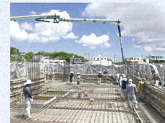
↑前回の打設状況(6階床)
